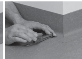
Recorte el revestimiento del suelo que se va a colocar. Trabajo terminado. sobre el zócalo.
