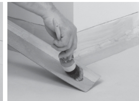
Aplique pegamento en el suelo y contra la pared hasta la línea.
